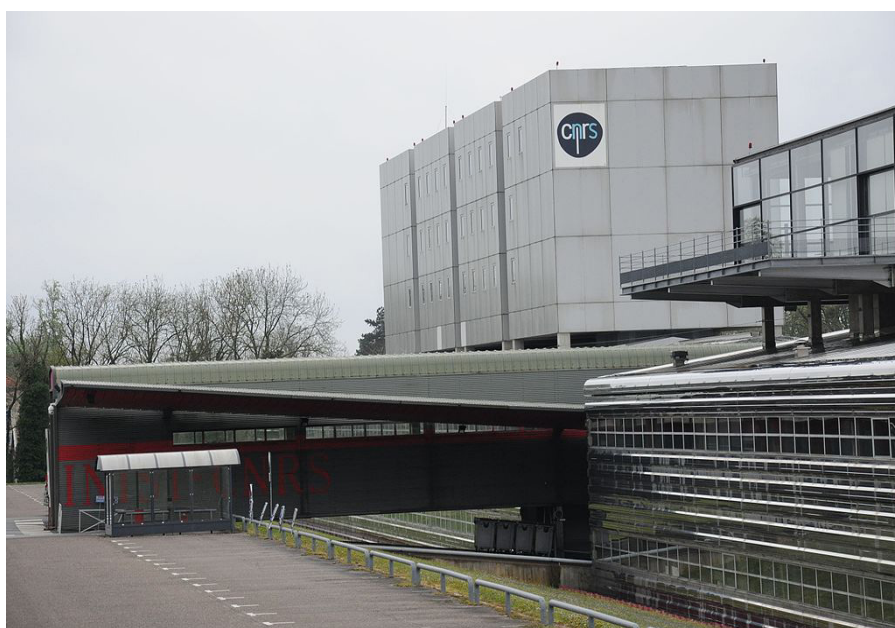
Vue extérieure du bâtiment de l'INIST
